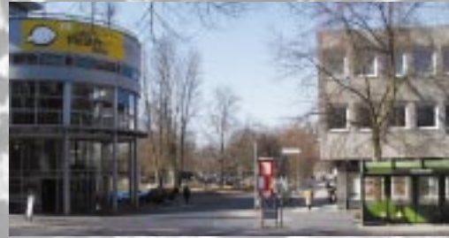
Der Zugang zum Schlosspark am Kleinen Haus im Ist-Zustand
