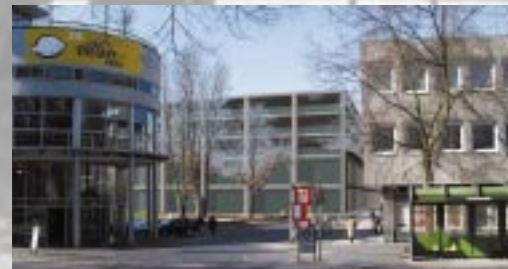
Nach dem Bau des ECE-Projektes - die oberen Geschosse sind Parkdecks
